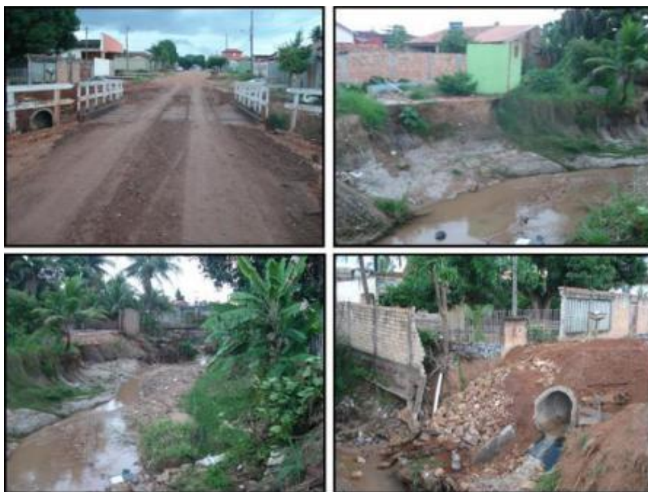
Figura 3: Pontos de lançamento de efluentes in natura no Igarapé Pintado.
