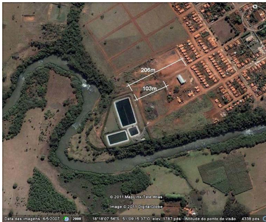
Figura 1: Imagem da ETE de Aparecida do Rio Doce e residências próximas.
