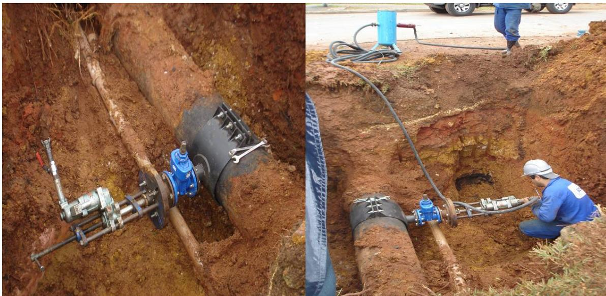
**Figura 06: Acompanhamento de furação de tubulação em carga para implantação de hidrante.**
