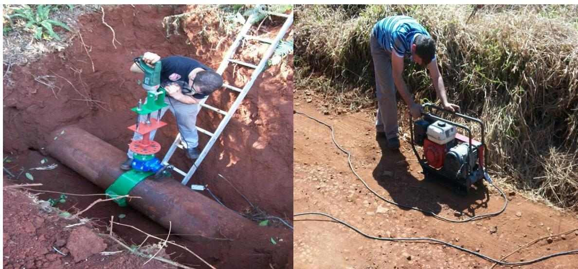
**Figura 08: Execução de furação de tubulação em carga para implantação de 12 ventosas na AAB Rio Pato Branco.**
