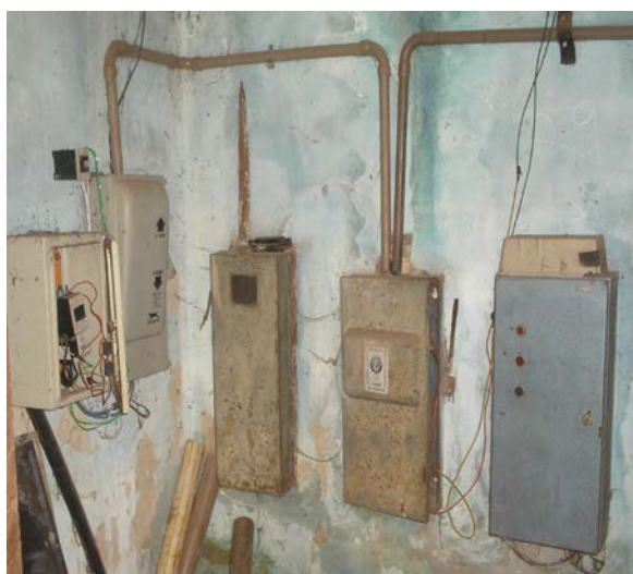
Figura 4: Instalações elétricas precárias do SAA de Benevides. Foto: Arquivo pessoal.
