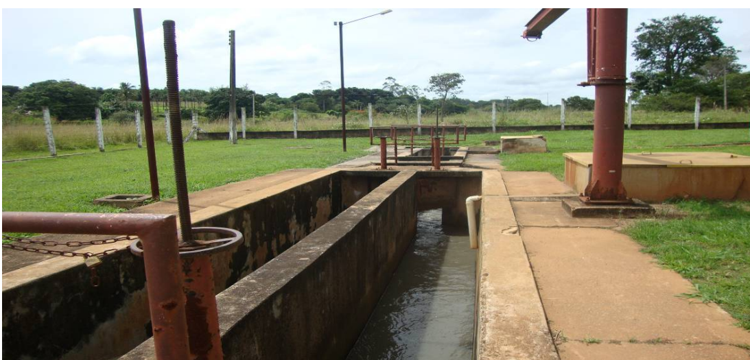
Figura 1: Local de lançamento dos lodos sépticos na ETE – Barro Preto.
