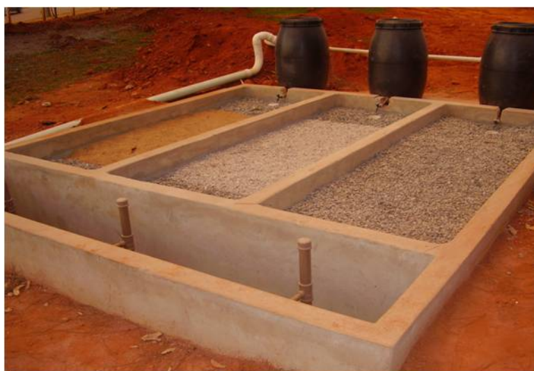
Figura 3: Detalhe de preenchimento dos leitos com os substratos. Da esquerda para a direita: areia, brita # 0 e brita # 1.
