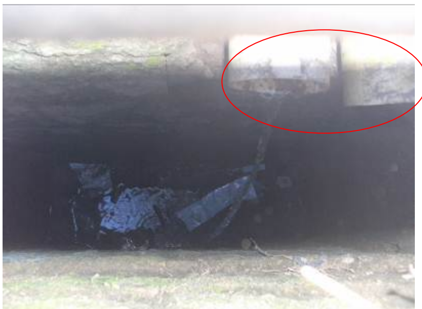
Foto 07: Lançamento de esgoto em boca de lobo de água pluvial. Local: Av. Gentil Bicalho.
