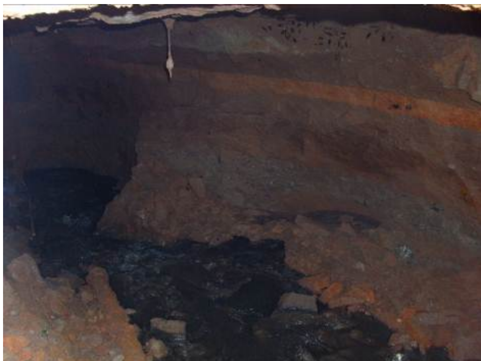
Foto 12: Terreno cedendo na Avenida Getúlio Vargas. Ocorre o cruzamento de água pluvial com esgoto.
