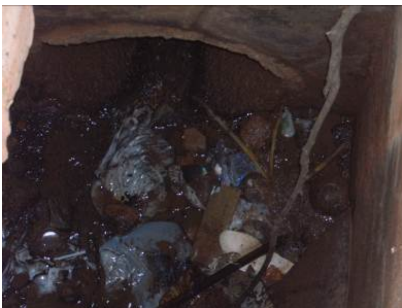
Foto 06: Cruzamento de água pluvial com esgoto. Bairro São João.
