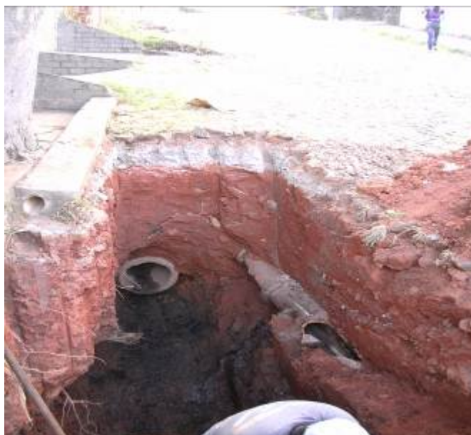
Foto 02: Canalização de esgoto rompida devido à pressão em terreno acidentado. Bairro Rosário.
