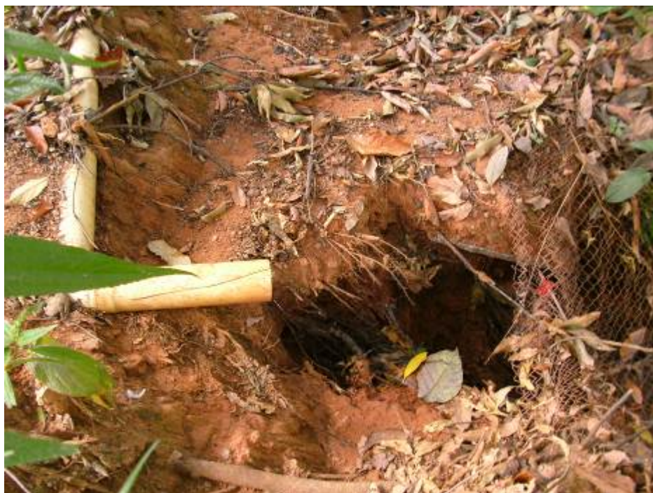
Foto 09: Fossa negra. Fonte de alto nível de contaminação do lençol freático. Bairro São João. Surgência de água bem próximo a esse local.
