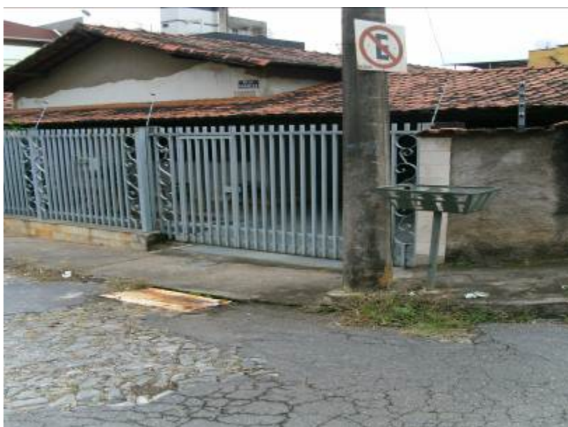
Foto 08: Boca de lodo coberta com placa de ferro em frente de uma residência, para evitar mau cheiro. Cruzamento de água pluvial com esgoto. Bairro: São Jorge.
