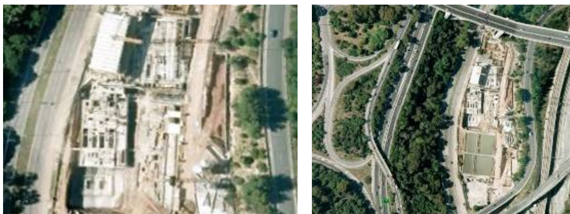
Figura 2: Vista geral da ETAR durante a Obra.
