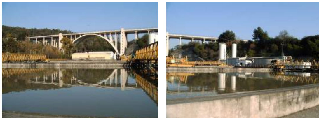
Figura 1: Vista geral da ETAR antes da Obra.
