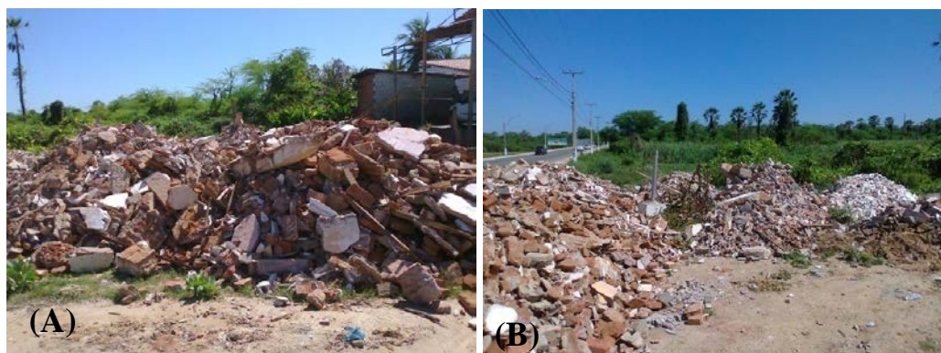
Figura 2: Vistas de deposições de resíduos da construção e demolição: (A) Detrito de Alvenaria e madeira; (B) Detrito de Alvenaria, gesso e madeira. Complexo Vight Rosado Neto, Bairro Alto da Conceição/Alto do São Manoel. Mossoró, RN, 19/08/11. Coordenadas geográficas: 5°12'28''S 37°20'26''W.
