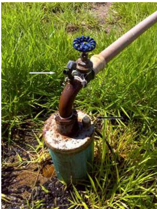
Figura 3: Poço dotado de torneira com registro para coleta de água (seta branca) e orifício para sondagem de nível freático (seta preta). Fonte: arquivo pessoal dos autores.
