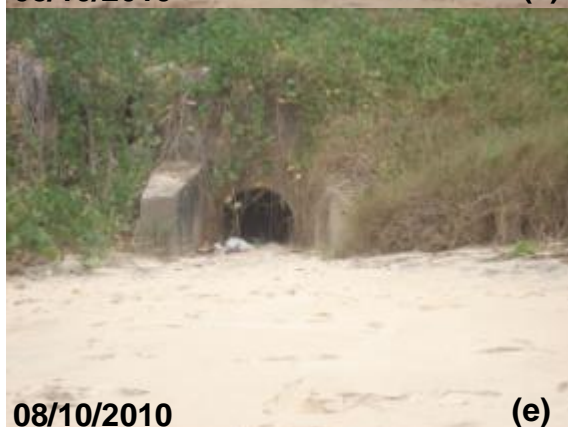
Figura 73: Nas fotos (a, f) é observado que existem ligações clandestinas de esgotos nas galerias de drenagem. Nas demais fotos o que é verificado é o possível avanço do mar em direção as galerias aportando sedimentos que obstruem a passagem das águas
