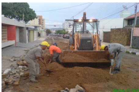
Figuras 7: Trabalhos de implantação de redes distribuidoras e demais conexões. Fonte: Acervo da COMPESA, 2011.
