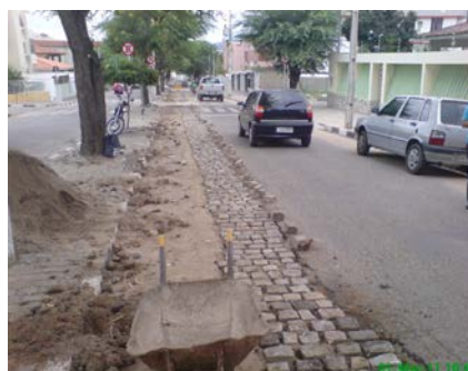
Figuras 8 e 9: Trabalhos de implantação de reposição de calçamento. Fonte: Acervo da COMPESA, 2011.
