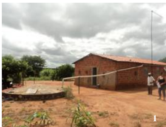
Figuras 1 e 2: (1) calha de coleta de água de chuva; (2) estado de conservação
