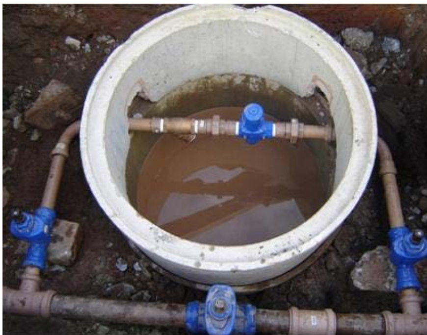
Figura 3: Fase de instalação da Válvula
