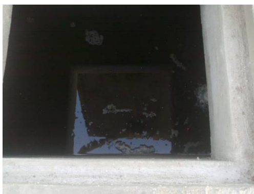
Figura 5. Água acondicionada na cisterna do campus de Pombal da UFCG. Fonte: Autores.
