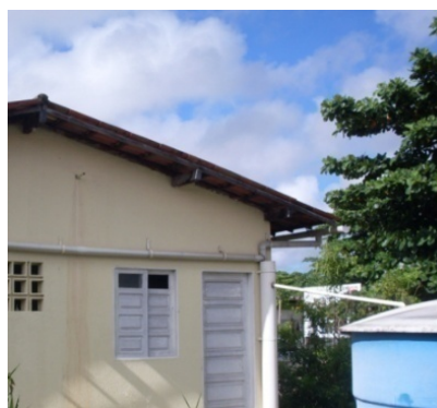
Figura 1: Estrutura de captação e transporte da água de chuva (AGRA, 2011).
