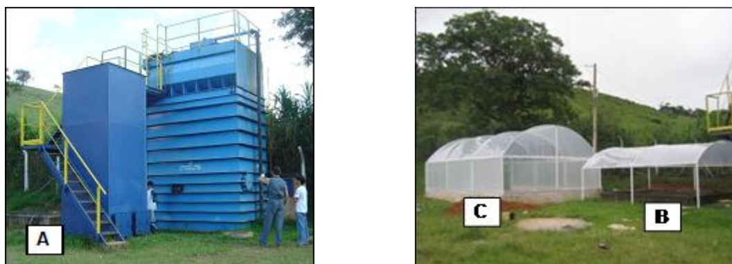
Figura 1 – Unidade Integrada de Tratamento e Utilização de Esgotos Sanitários da Viçosa, Viçosa – MG: (A) reator UASB e biofiltro aerado submerso. (B) leitos de secagem. (C) estufa de secagem.
