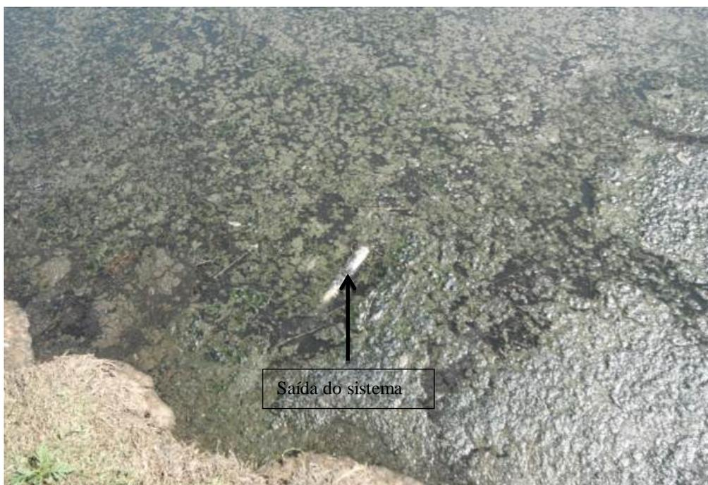
**Figura 6: Lagoa anaeróbia com excesso de material flotado.**
