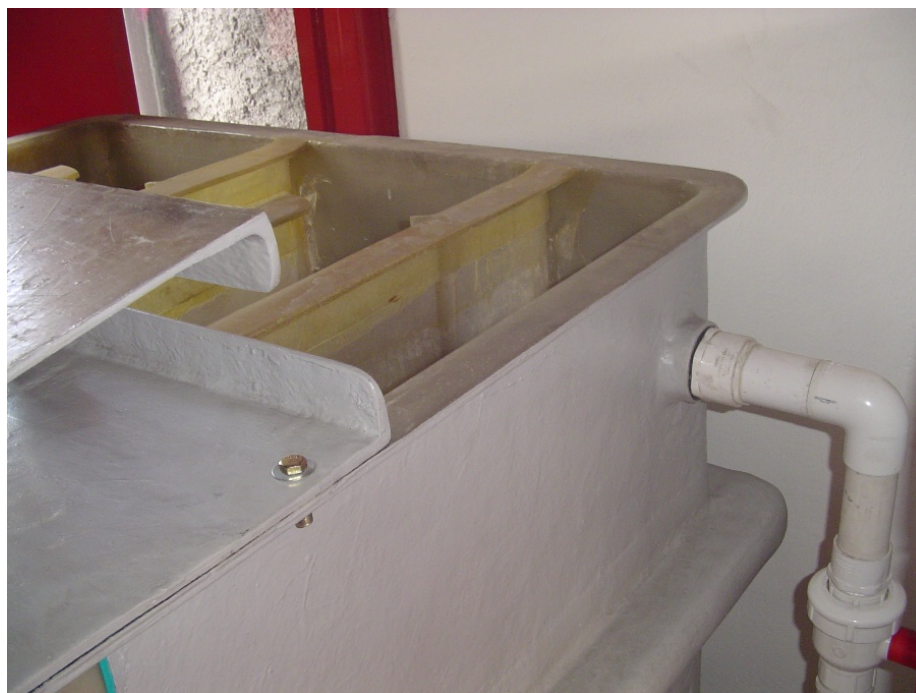
Figura 4 Salida del tanque de contacto. Sitio de la toma de muestra de agua desinfectada
