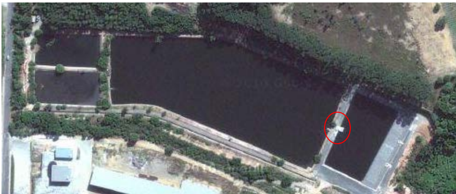
Figura 3: ETE CIVIT II e local da implantação da unidade.
