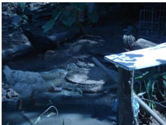
Figura 4a: Transbordo no interceptor de esgoto.
