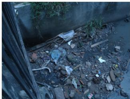
Figura 4b: Obstrução das galerias devido ao arraste de lixo e entulho para dentro do córrego.
