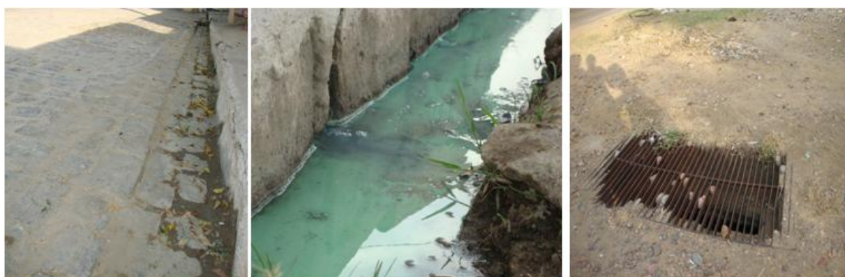
Figura 02: Esgotos correndo a céu aberto no bairro Pedra do Lorde.
