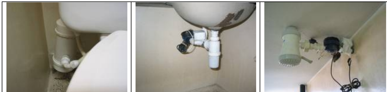
Figura 12 – Equipamento (hidrômetro+datalogger) instalado em uma caixa acoplada; lavatório e chuveiro).
