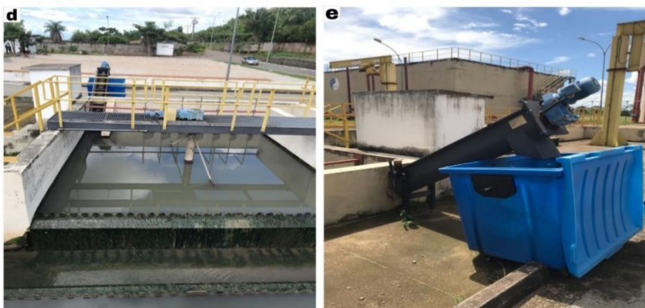
Figura 05: Processo de Desarenamento e Coleta de rejeitos. Desarenador (d) e Coleta de Resíduos (e).
