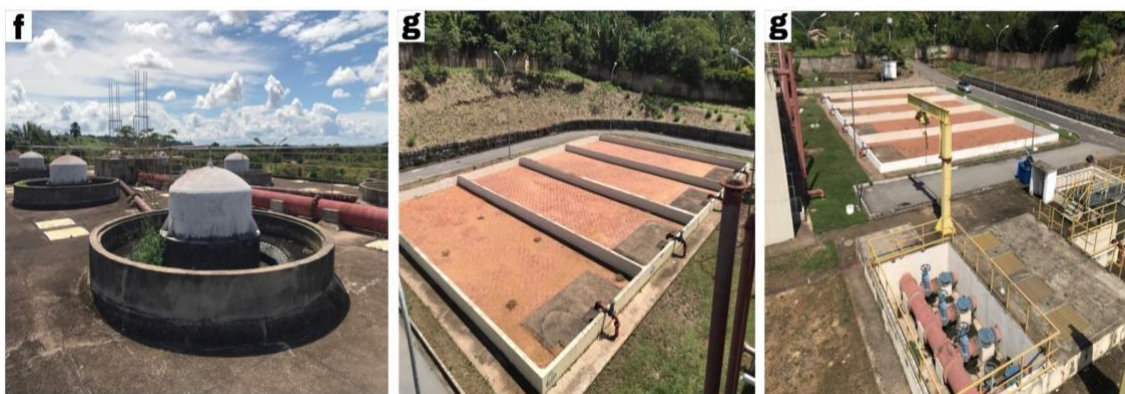
Figura 06: Reator UASB (f) e Leitos de Secagem (g).
