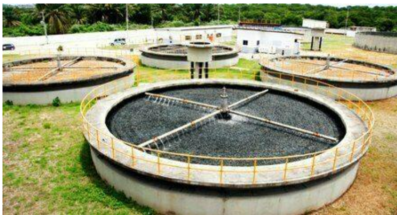
Figura 2. Filtro Percolador da ETE Dancing Days (Ponto de Coleta do esgoto tratado).
