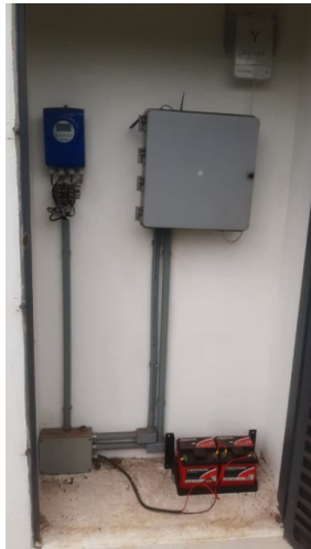
Figura 4 – Vista lateral nicho e caixa da TRP
