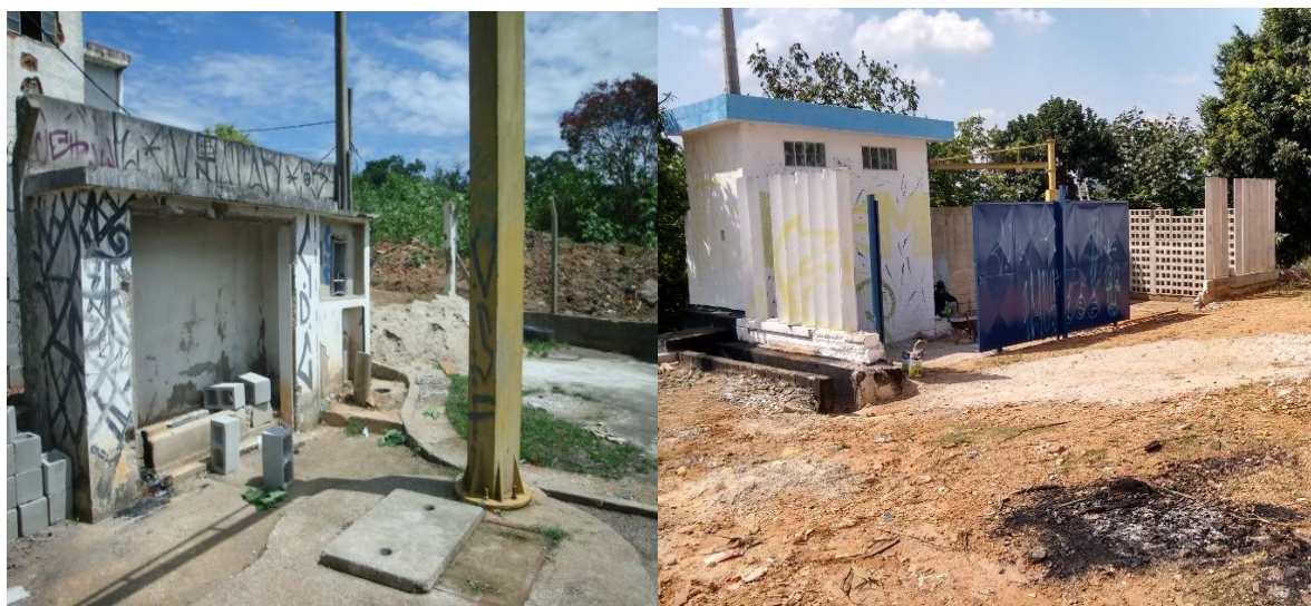
Figura 3 e 4: Estação Elevatória Boa Vista antes(vandalizada) depois(recuperada)
