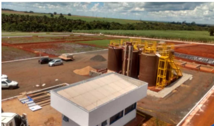
Figura 3: Reatores UASB ETE Pirajuba Fonte: Copasa
