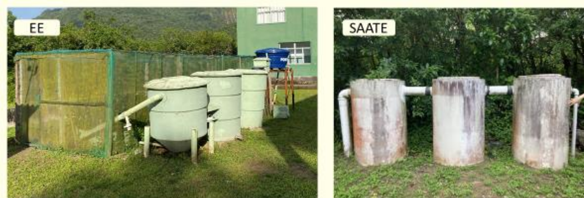
Figura 2: Fotografias do Ecossistema Engenheirado à esquerda e do Sistema Anaeróbico Avançado de Tratamento de Esgoto à direita.
