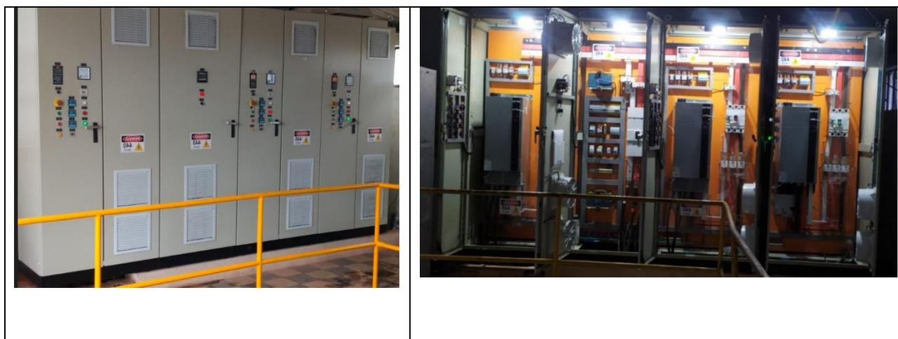
**Figura 4 – Novo painel de acionamento**
