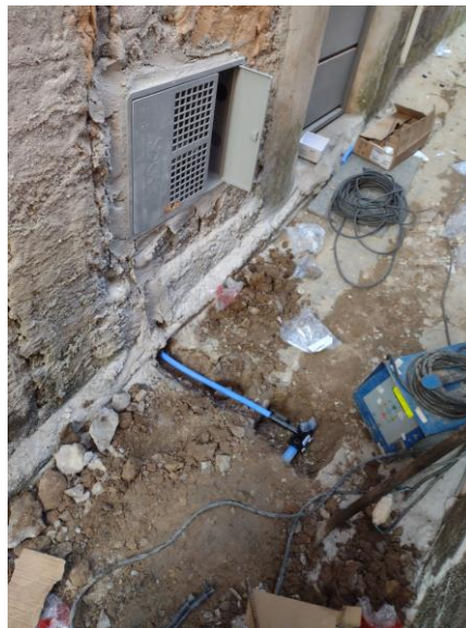
Figura 12: Exemplo de regularização, Ponte Alta
