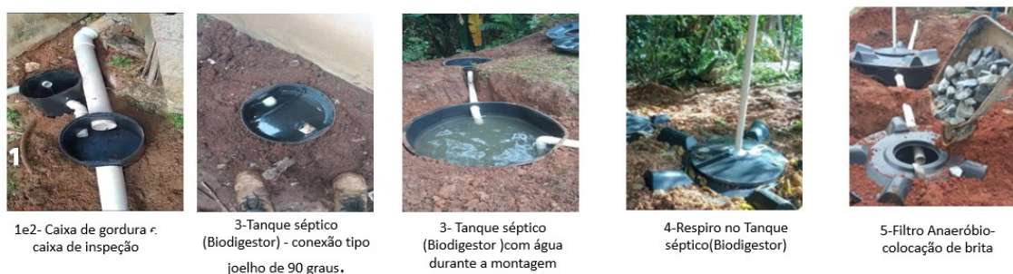
Figura 1: Instalação de Unidade Sanitária Individual – USI
