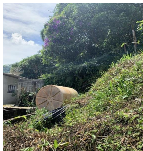
b) Reservatório arrastado pelo deslizamento
