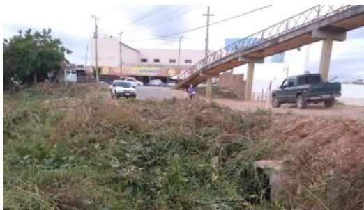
Figura 4: Acesso de veículos e pedestres, com tubulação.
