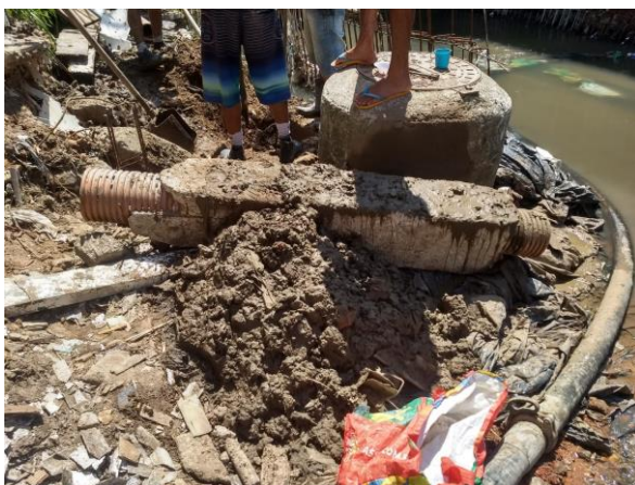
Figuras 04 e 05: Tubulações danificadas.
