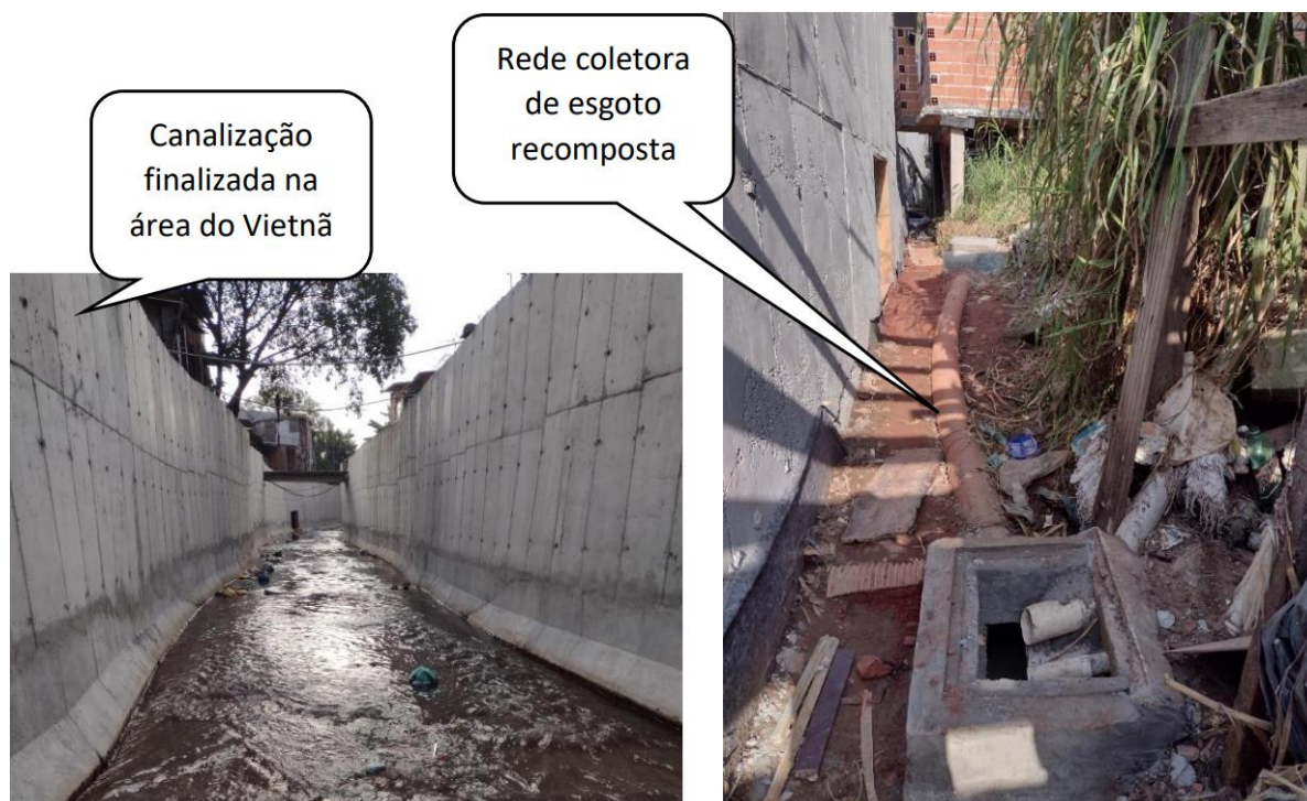
Figuras 10 e 11: Córrego canalizado e rede coletora recomposta.
