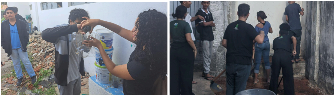
Figura 12 e 13: Implantação das estruturas. Fonte: Acervo pessoal, 2023
