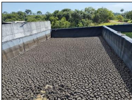
Figura 2 – Leito de secagem usado para desidratação do lodo da ETE.
