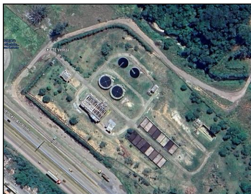
Figura 1 – Vista aérea da ETE Veneza.
