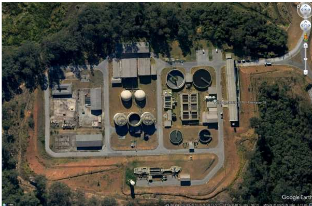
Figura 1: Estação de Tratamento de Esgoto de Ibirité (1ª etapa).
