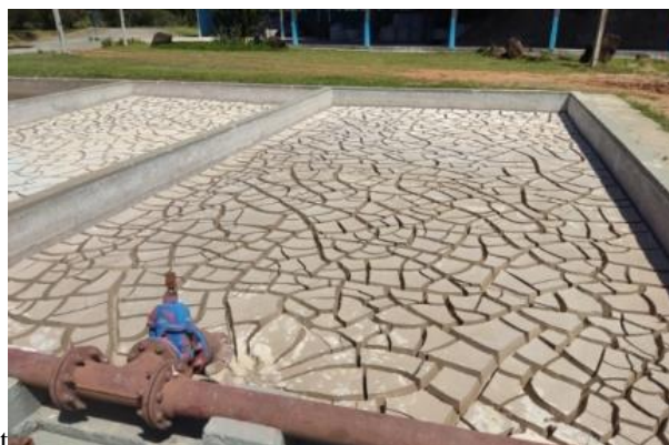
Foto 7 - Torta de lodo em leito de secagem pronta para ser retirada FONTE: Autor (2023)
