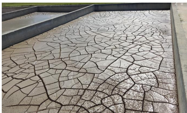
FIGURA 5 - Lodo em leito de secagem em processo de desidratação após 24 horas FONTE: Autor (2023)
