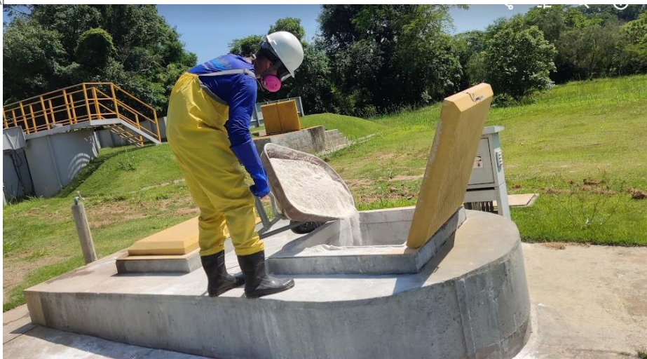
Foto 2 - Adição da cal virgem na Estação Elevatória de Lodo (EEL) FONTE: Autor (2023)
