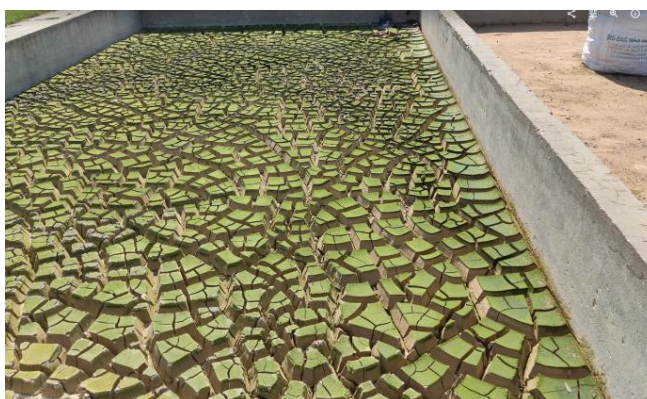
Foto 6 - Lodo desidratado em leito de secagem pronto para ser retirado após 72 horas FONTE: Autor (2023)
