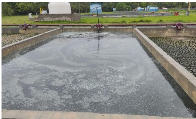
Foto 4 - Lodo em leito de secagem. Refere-se à aplicação da cal virgem na descarga FONTE: Autor (2023)
