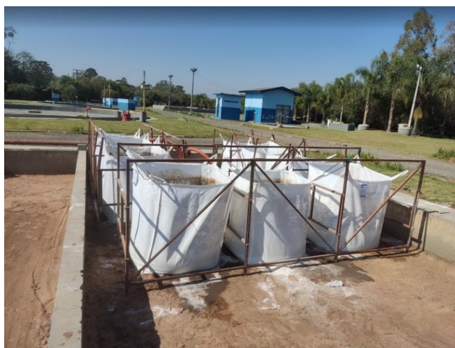
Foto 3 - Estrutura metálica com bolsas drenantes FONTE: Autor (2022)
