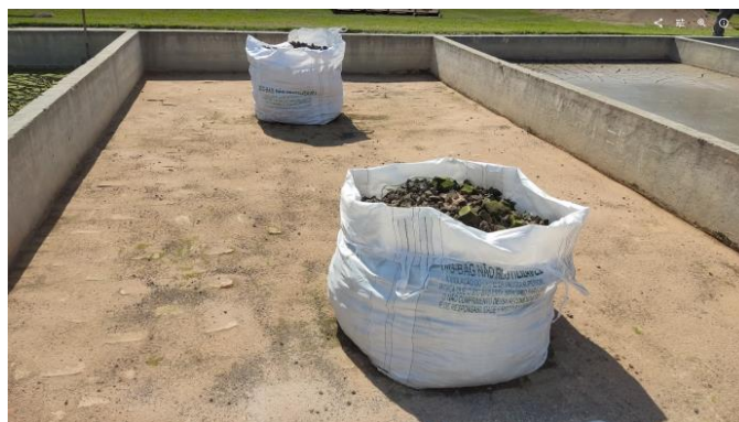
Foto 8 - Lodo em leito de secagem. Embalado para ser levado à Unidade de Gerenciamento de Lodo (UGL)
