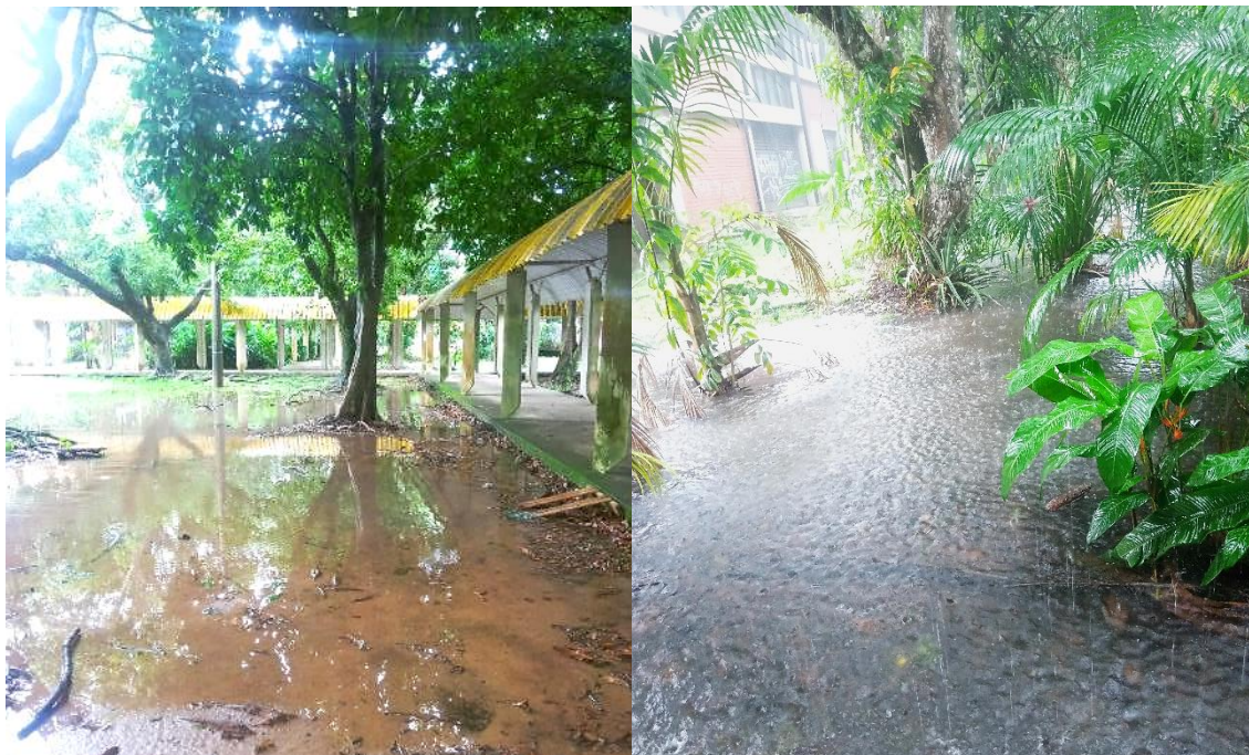
Figura 4: Pontos de acúmulo de água na Sub-bacia B1.
