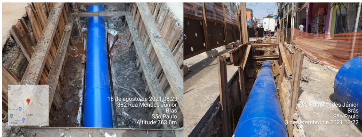
Figura 8- Inserção do tubo de PEAD 800 mm (Sliplining)
