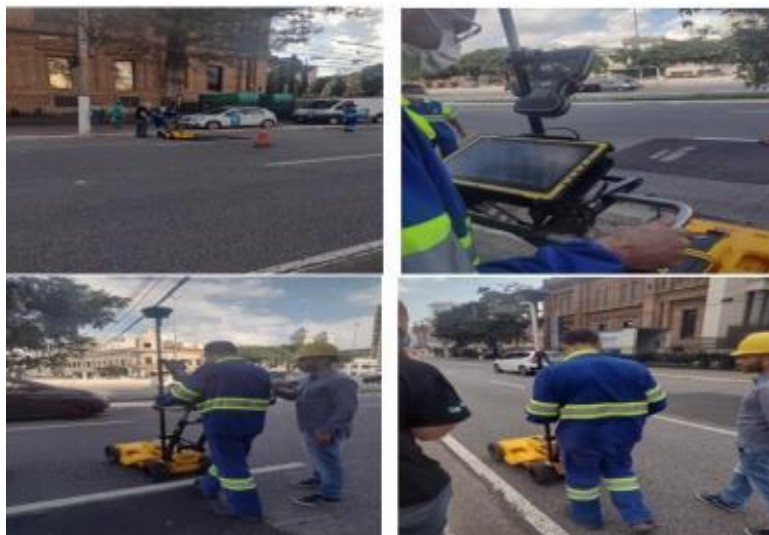
Figura 4 – Investigação de subsolo com Georadar
