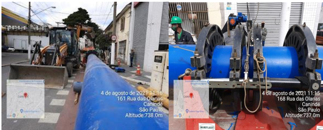
Figura 6 – Soldagens das colunas de 800 mm
