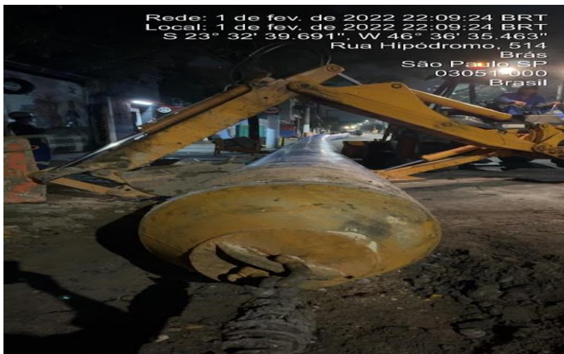
Figura 7 – Coluna de 800 mm preparada para o puxe
