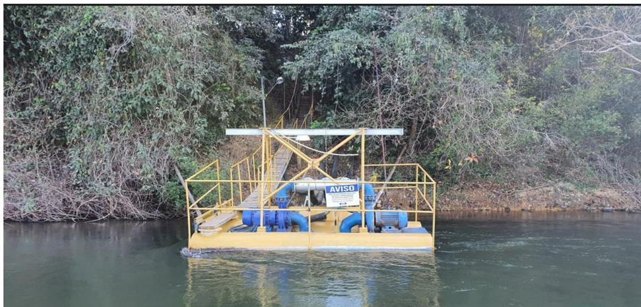
Figura 9 - Embarcação de captação de água para abastecimento de Nova Xavantina, SETAE.
