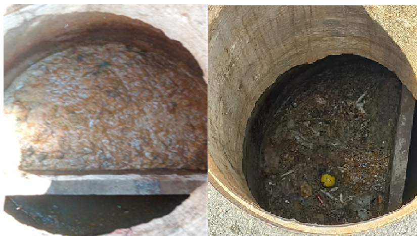
Figuras 5 e 6 - PV-IGS antes e depois da aplicação da biorremediação. Fonte do autor.
