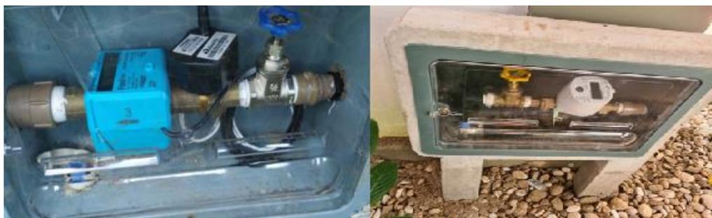
**Figura 5 – Hidrômetros de consumidores instalados para os testes. Fonte: Autores do artigo.**
