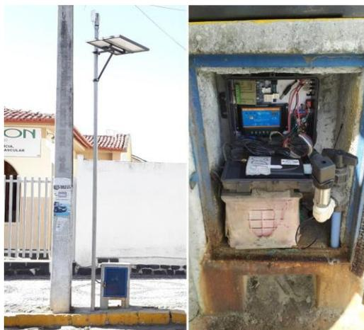
Figura 7 – Estrutura de monitoramento de pressão. Fonte: Autores do artigo
