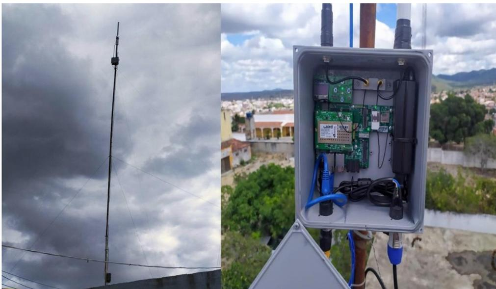
Figura 3 – *Gateway* LoRaWAN instalado no reservatório apoiado na cidade de Senhor do Bonfim.
