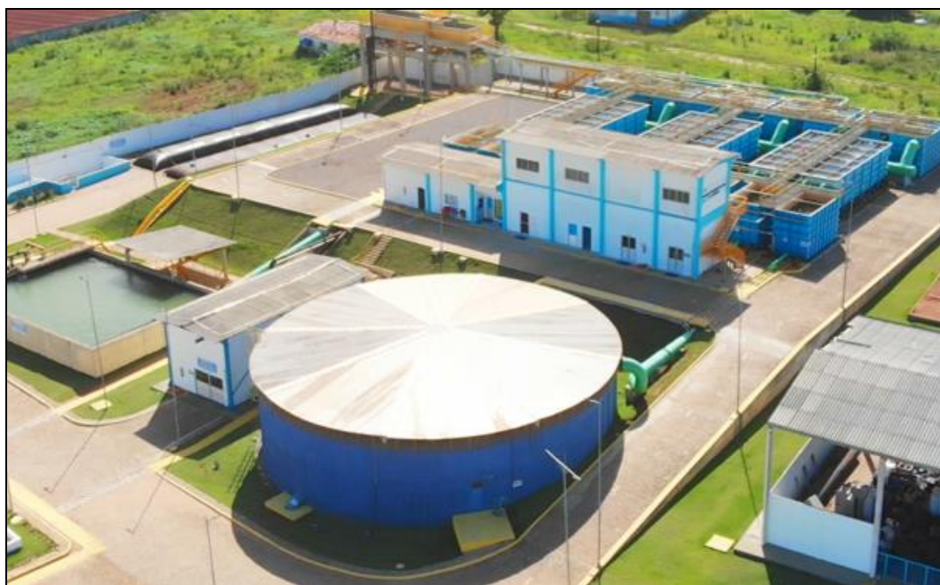
Figura 1: Estação de Tratamento de Água (ETA) Arapiraca.
