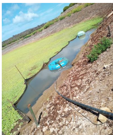
Figura 6 - Barreiras instaladas na Captação 3. Fonte: Autor (2024)
