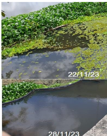
Figura 1 - Barreiras de contenção, na captação 1, antes e após instalação. Fonte: Autor (2023)
