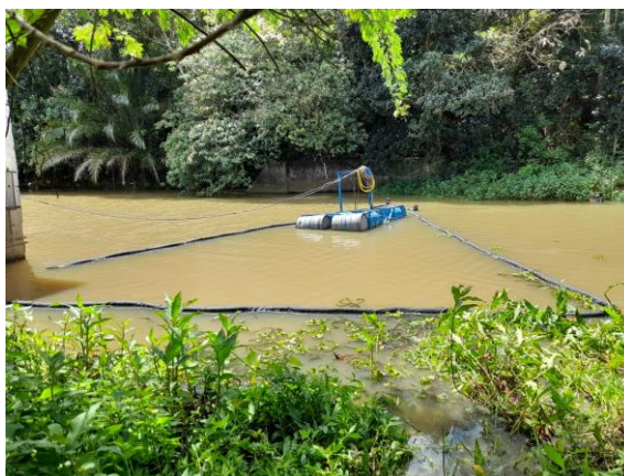
Figura 3 - Barreira de contenção na captação 2. Fonte: Autor (2024)
