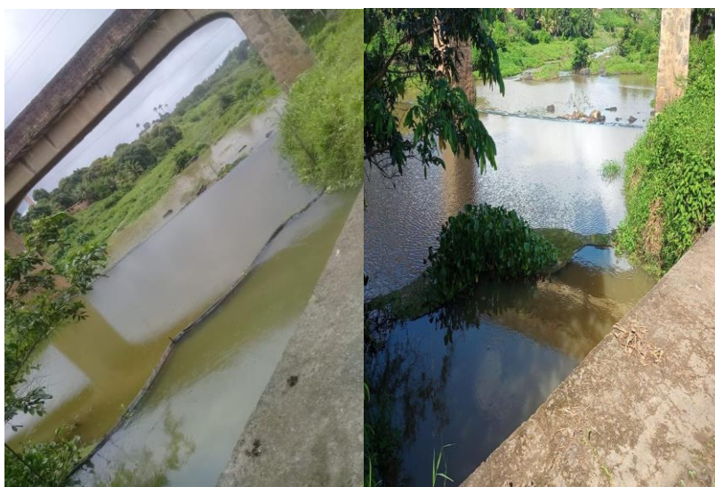
Figura 2 - Barreiras de contenção, na captação 1, período de chuvas fevereiro de 2024 (esquerda) e maio de 2024 (direita). Fonte: Autor (2024)
