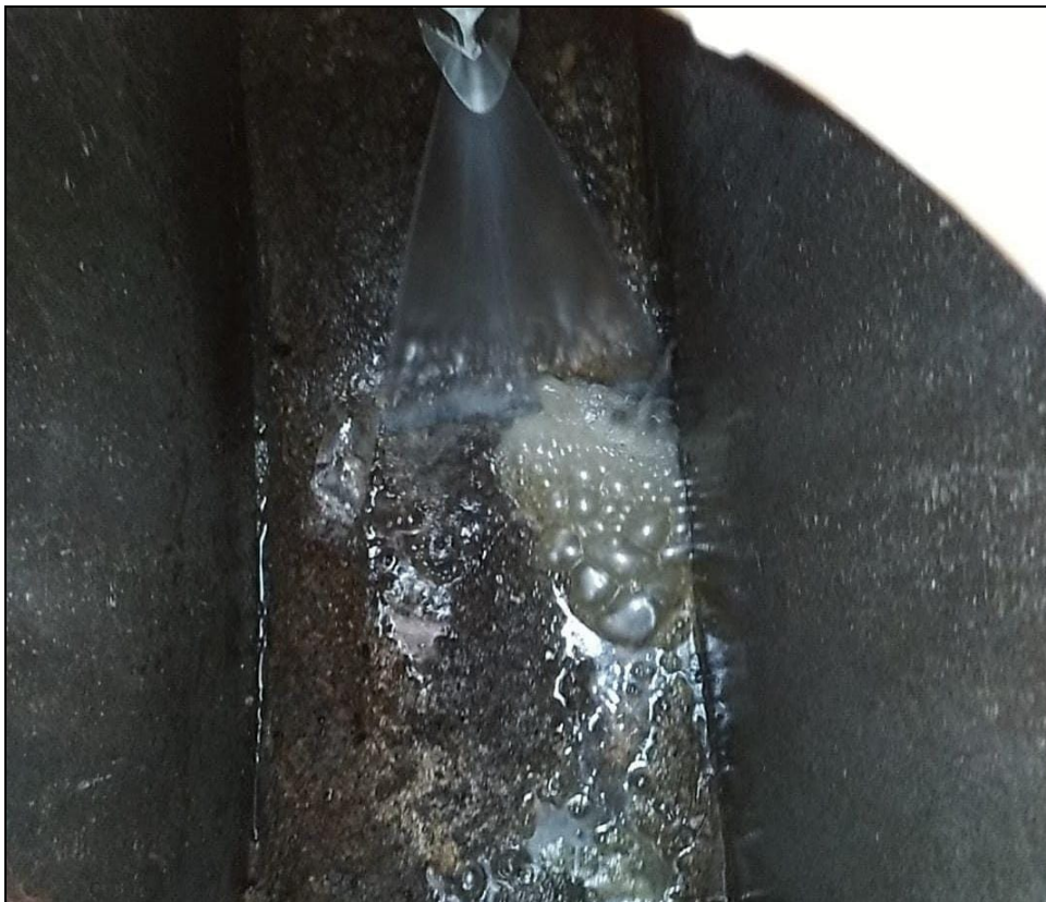
Figura 2: Aspersor no canal antes da modificação
