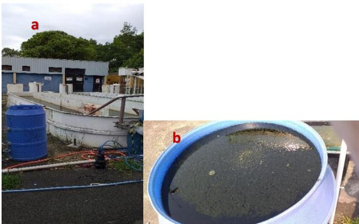
**Figura 4a e 4b: bombona de coleta, dosagem Tanfloc e separação**
