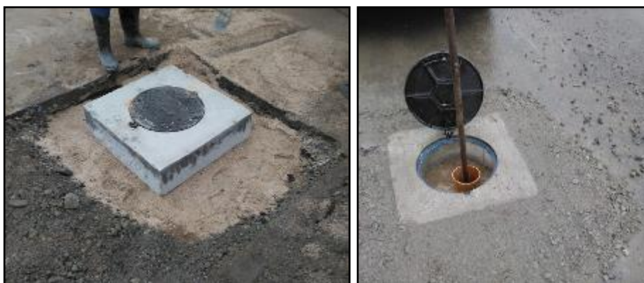
Figura 12 – Tampa de acesso as válvulas, fechada sendo instalada (a), instalada e aberta em uso (b)
