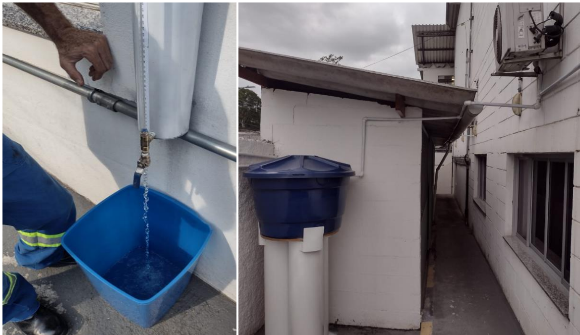
Figura 4 – Realização de Piloto para reaproveitamento da água condensada/gerada nos aparelhos de ar condicionado.
